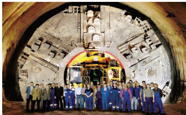
Equipo de trabajadores junto a máquina taladradora de túneles
