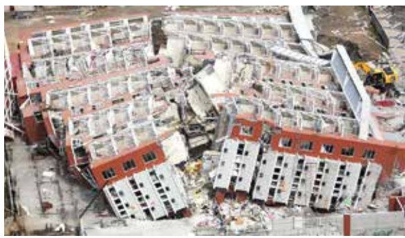
Figura 1.24 Edificio destruido por el terremoto de magnitud 8,2 en la escala de Richter, ocurrido en febrero de 2010 en Chile
