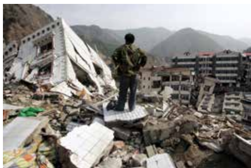
Figura 1.23 Daños ocasionados por el terremoto en China en mayo de 2008, cuya magnitud fue de 8,2
