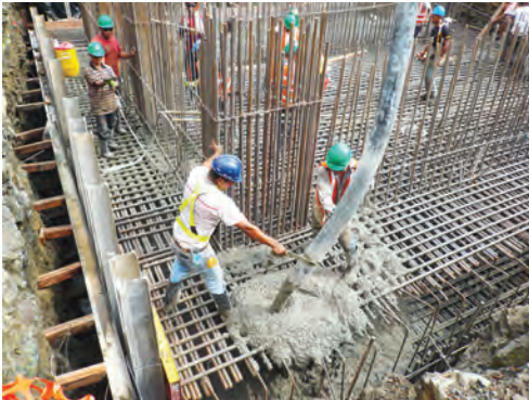
El cemento es utilizado en las construcciones para rellenar cimientos, estructuras, etc.
