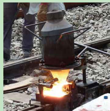
La aluminotermia es utilizada en el proceso de soldadura en la construcción de rieles de vías férreas
