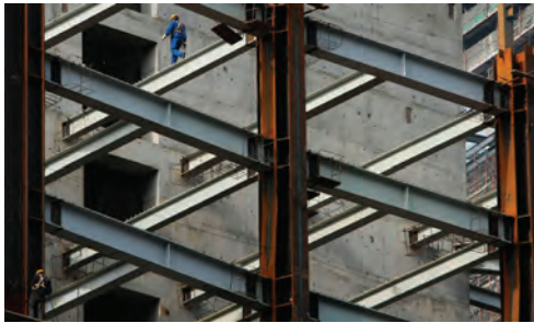
Estructura de acero de un edificio en construcción
