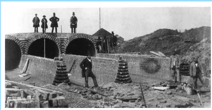
— Construcción de las cloacas en Londres, 1862
